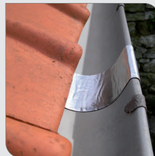
Поправка на повредени улци.
