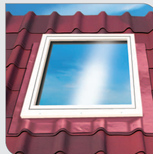
Обшивка на покривни прозорци.
